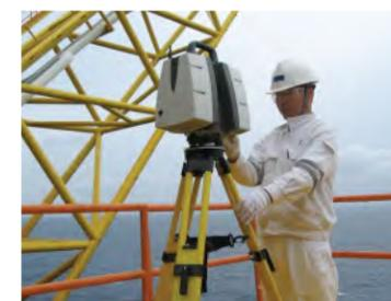
海油工程在恩平油田群总包工程项目中，中海油深技服平台改造人员运用基于数字集成一体化改造技术的“魔笛系统”助力海上平台改造。该系统通过三维激光扫描仪快速精准采集数据，数据准确度较人力调研平均提升近20%；利用数据构建超高清三维模型，验证施工方案可行性，将陆地预制率从60%提升至85%，降低海上施工成本；还能通过AR虚实叠加实现厘米级定位，全流程辅助改造作业。目前已在多个工程成功应用，海油工程后续将深化数字化技术应用，推动油气田开发智能化转型。
