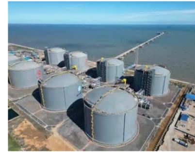
9月21日，海油工程总承包的唐山LNG接收站二阶段工程提前21天完工投产。该项目是环渤海地区最大LNG接收站，规划建设**20座20万立方米**储罐，对优化京津冀能源结构意义重大。公司发挥EPC全产业链优势，联合研发中心建立联动循环机制，推动项目加速。项目团队创新技术工艺，借助“Checklist”清单保障安全施工，多项自动化技术提升建造水平。
