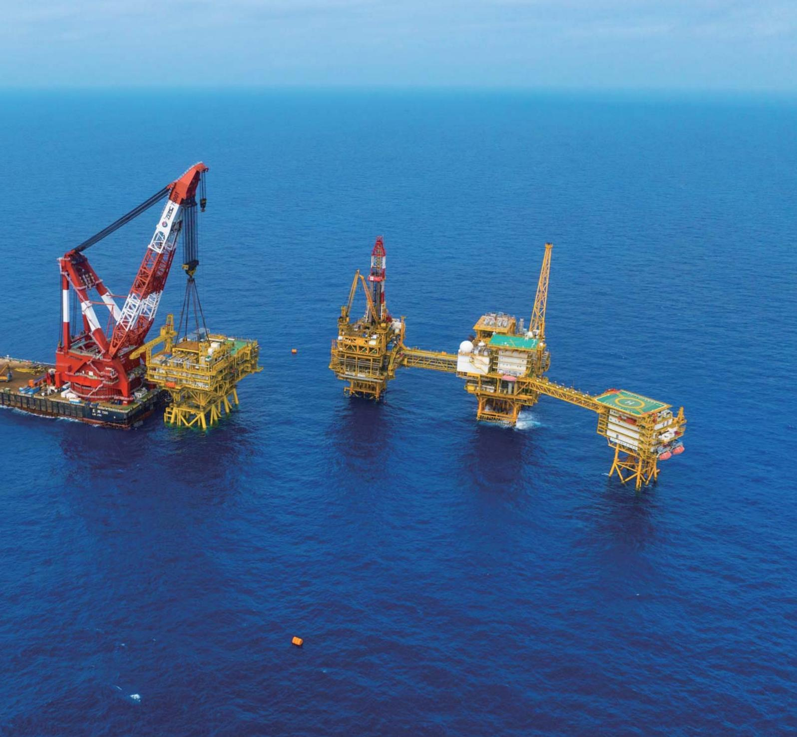
“深海一号”二期工程自主建设完成全球首套千米级深水自动发球管汇、国内最长深水油气管道、系列首台套深海水下生产装备等关键设施，工程建设速度、质量、安全、精度等均达到国际先进水平，“深海一号”超深水大气田开发工程关键技术与应用获评国家科技进步一等奖。
